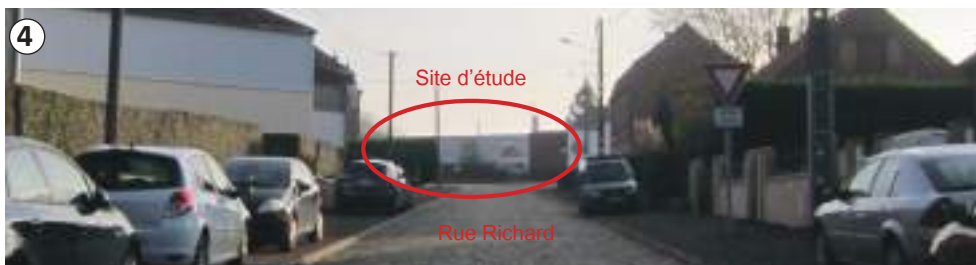
Vue depuis la rue Richard à l'ouest : les vues sont possibles et sont ouvertes vers le bâtiment existant qui sera à démolir.
