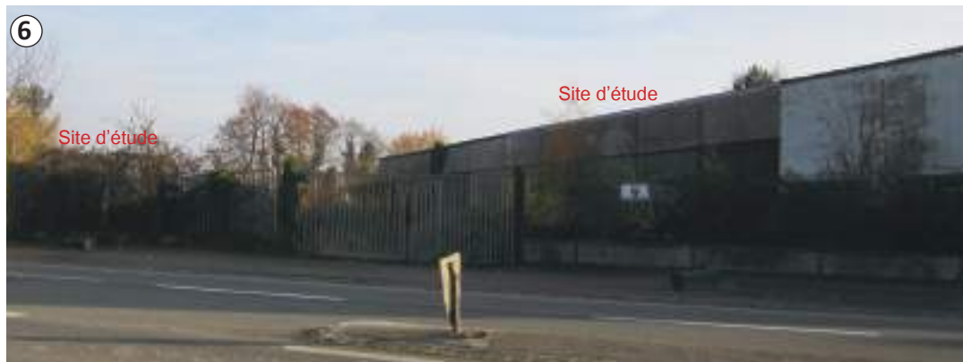
Vue depuis la RD643 au sud : le bâti à démolir est bien visible, une clôture l'est également. L'intérieur de la zone est difficilement visible derrière la végétation existante sur les franges de la zone.
