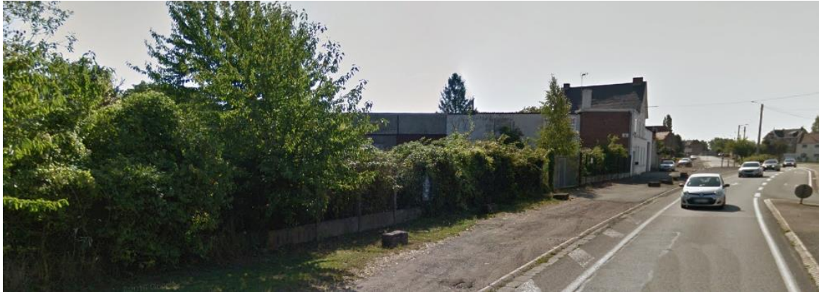
A gauche : La zone d'étude bordée d'une clôture et de végétaux – vue depuis la RD643
