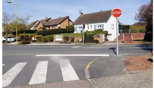
Pose d'un stop rue Joliot Curie.
