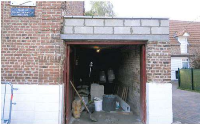
Travaux sur le fronton du garage de la commune
