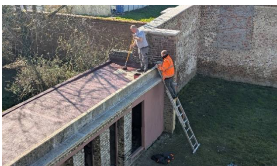
Etanchéification de la toiture des dépendances par les agents communaux
